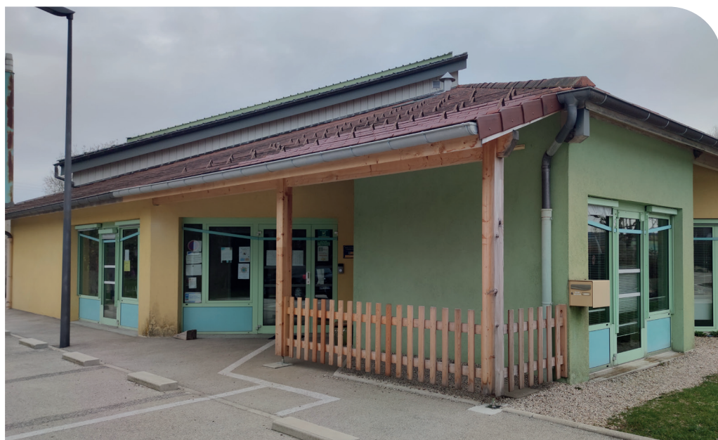
Réalisation 2022 - Abri de bus à l'école, coût des travaux 6 500 euros TTC
