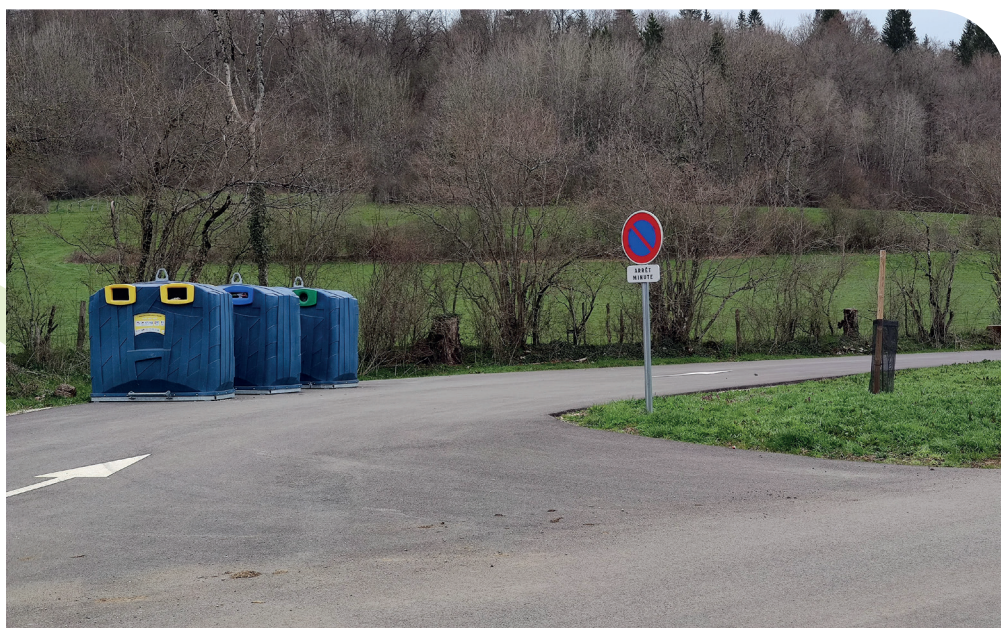
Réalisation 2022 - Point d'apport volontaire route de saint Lazare
