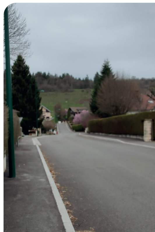
Réalisation 2022 fin de la réfection de le rue de la Louvière
