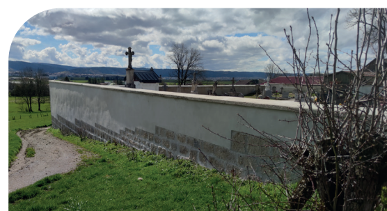
Réalisation 2022 - Réfection du mur du cimetière
