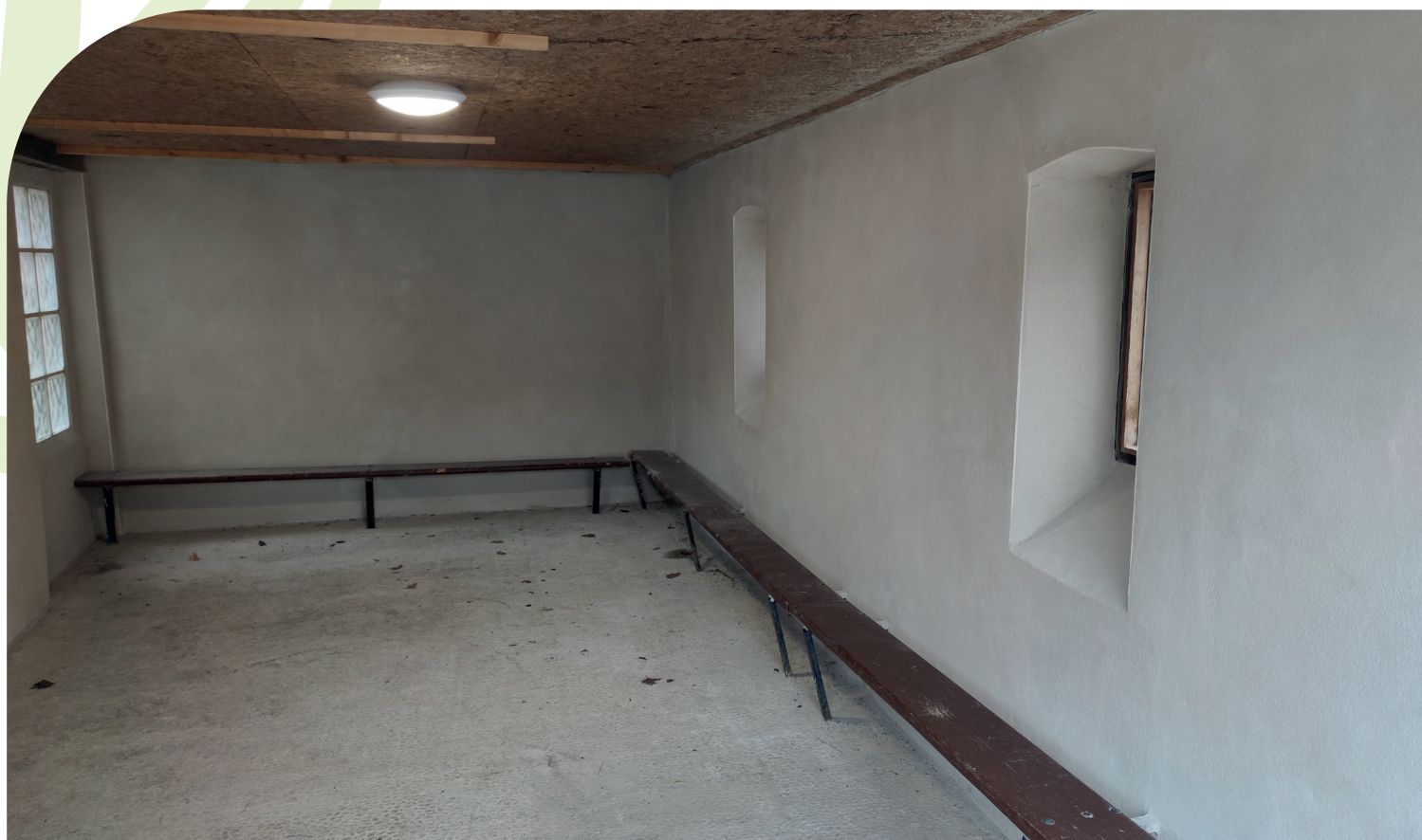
Réalisation 2022 - Refection de l'intérieur poids public
